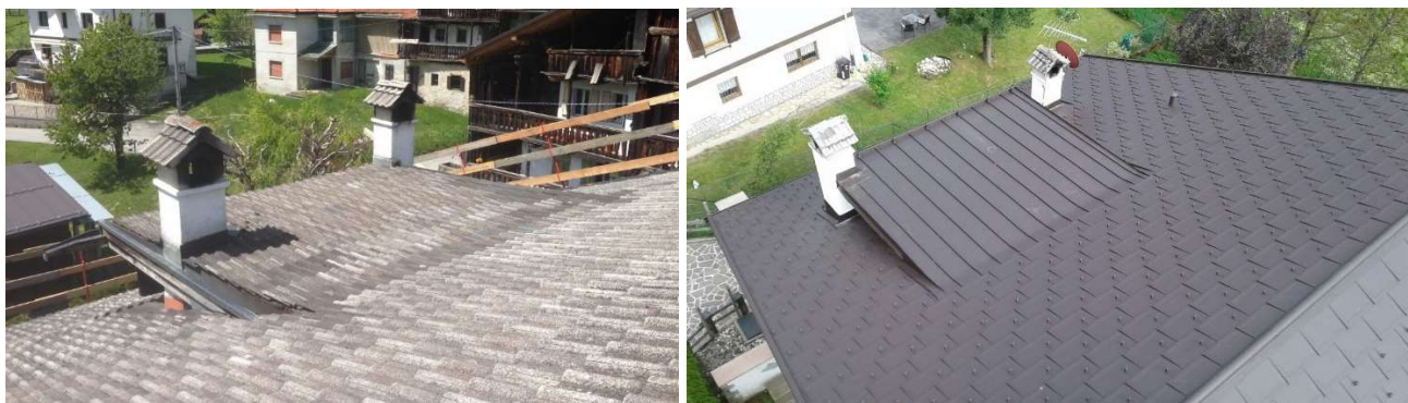
La copertura prima e dopo l'intervento di ristrutturazione
