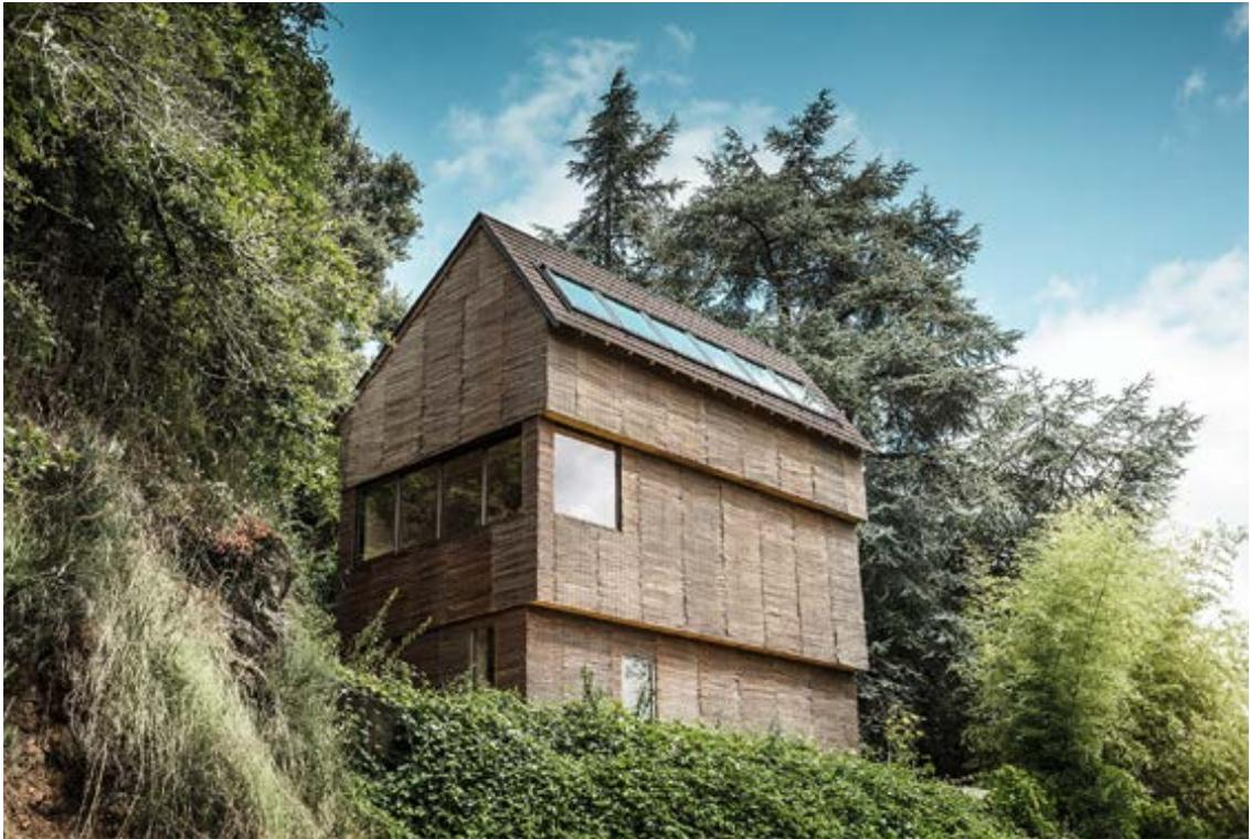
rivestite con pannelli di pino marittimo. Un vano scala aperto, le cui travi in legno diagonali e orizzontali svolgono una funzione statica, collega tutti e tre i livelli per formare un continuum in termini spaziali. Solo i “punti d’acqua”, un bagno e un WC al piano terra, sono tenuti separati da tende.
