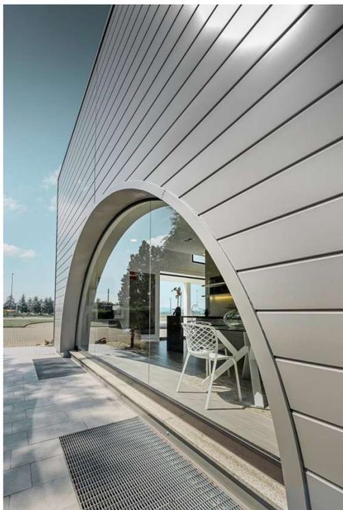
Per realizzare un rivestimento durevole, elegante ed energeticamente efficiente, il progettista **Arch. Giorgio Pecorari** ha scelto di intervenire ricorrendo alla tecnologia della **facciata ventilata** realizzata mediante una struttura reticolare leggera in legno e alluminio, funzionale al sostegno dei **rivestimenti in doghe di alluminio PREFA**. Il nuovo rivestimento crea una quinta di coronamento alla facciata principale che dona un effetto armonioso all'insieme.
