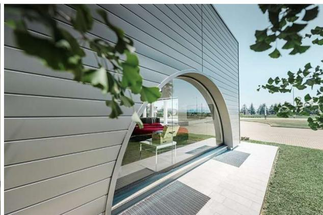
Il rivestimento in doghe in alluminio preverniciato **PREFA**, selezionato dal progettista per le sue caratteristiche di elevata resistenza, leggerezza e affidabilità, per la **garanzia quarantennale sul materiale** e la costanza del colore nel tempo, è stato facilmente fissato con viti e rivetti alla sottostruttura in legno ancorata alla muratura.
